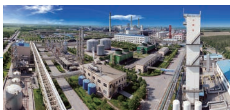
Dingzhou, Hebei 河北定州
